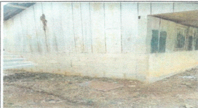
Foto 1: Ambiente a remozar en ambas culatas.
