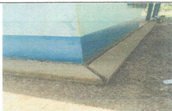
Foto 5: Sustitución de banquetas por deterioro.
